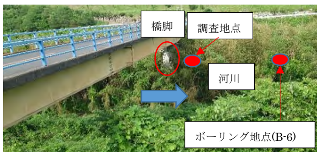
図-1 調査地状況(対岸より臨む)
