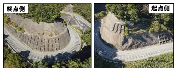
写真-1 調査のり面全景
