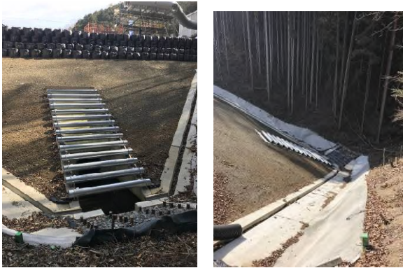
写真-3 盛土面に閉塞軽減工を設置し函渠に導流する例
