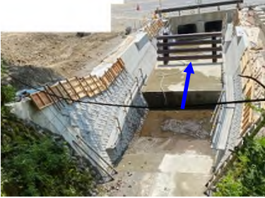
写真-2 閉塞軽減工を設置し函渠に導流する例(その2)
