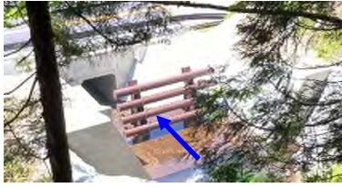
写真-1 閉塞軽減工を設置し函渠に導流する例(その1)
