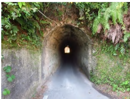
写真-1 起点側坑口
