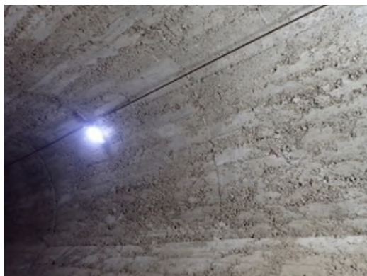
写真-2 覆工表面状況
