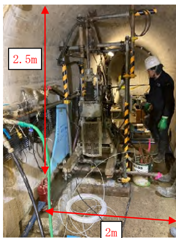
図-1 監査廊内での仮設状況
