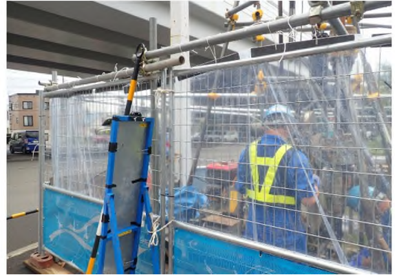
写真-4 泥はね防止シート設置状況
