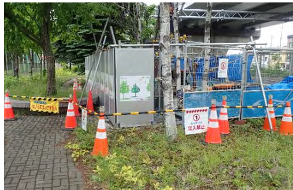
写真-1 吸音パネル設置状況
