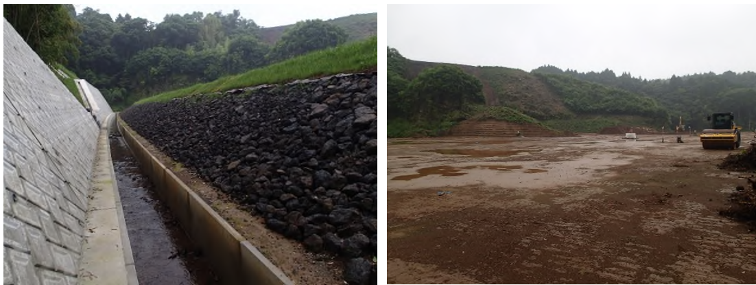
写真7 岩砕を用いた排水例(左)と縦排水への勾配を設けた盛り立て例(右)
