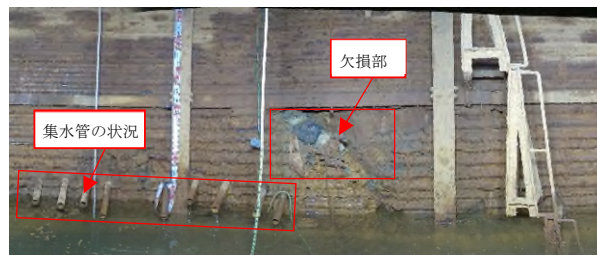
写真-2 集水井 1 のライナープレート損傷・集水管状況
