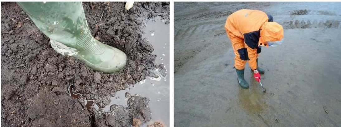
写真4 火山灰質粘性土分布域での雨天時状況（左；未処理土、右；石灰改良土）
