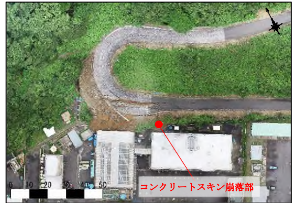
図-3 崩壊後写真
