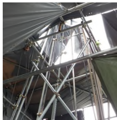
写真-1 防音シート仮囲い 上部開口部
