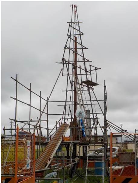
写真-2 ケーシング立ち上げ状況
