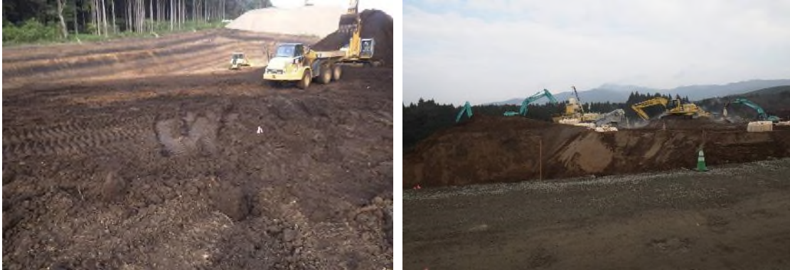
写真3 熊本県内の火山灰質粘性土分布域での改良工事事例
