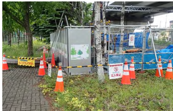
写真-1 吸音パネル設置状況
