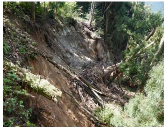
写真-2 頭部の滑落崖状況写真
