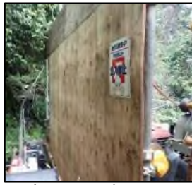
写真-6 コンパネの設置 (ボーリング地点で実施)
