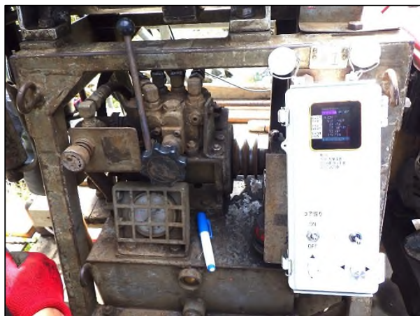
図-4 操作ユニットの現場設置状況
