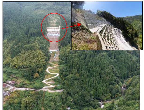
写真-3 現在の斜面对策状況写真
