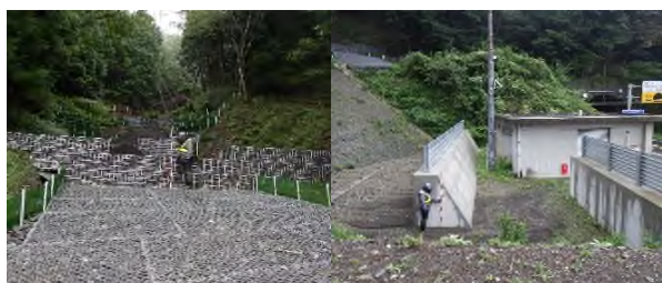
写真-3 既往対策工状況 例
