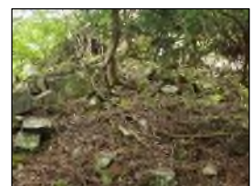
写真-4 岩盤の緩み箇所②
