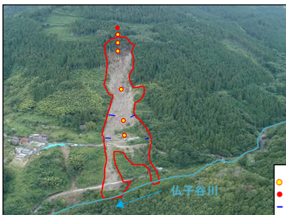
写真-1 災害発生後の斜面状況写真
