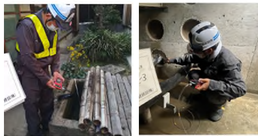
図-4 測定状況例（左：井戸，右：地下室）
