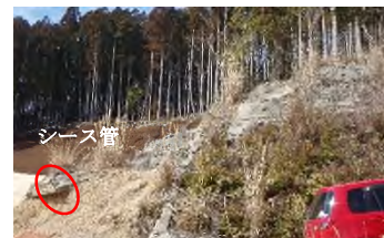
写真-1 のり面周辺状況写真
