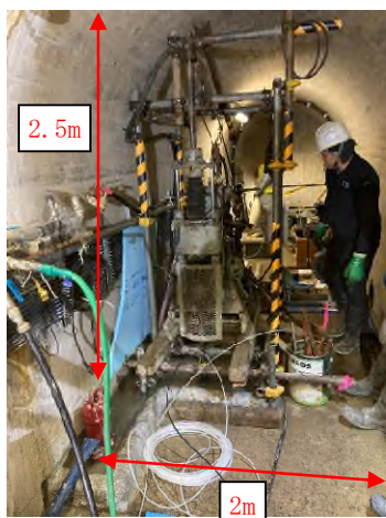
図-1 監査廊内での仮設状況
