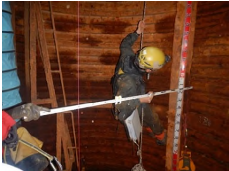
写真-4 下げ振り子による調査状況
