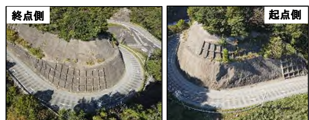
写真-1 調査のり面全景
