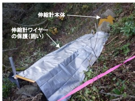
図-5 パイプの横ずれ防止のための囲い(S-1)
