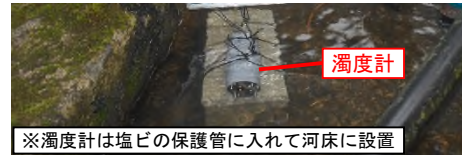
写真-1 濁度計の設置例 (沢)
