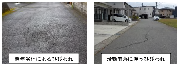
図-3 現地点検の着目点の例①
