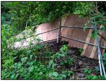
写真-5 簡易落石防護柵 (岩盤の緩み箇所①②で実施)
