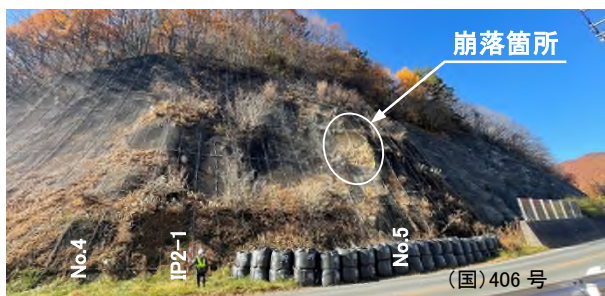
写真-1 対象法面全景
