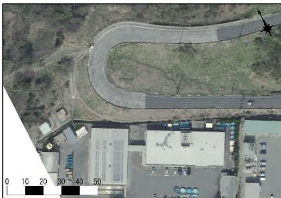
図-2 崩壊前写真 2)
