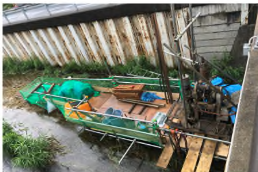
図-1 現地状況写真
