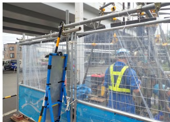
写真-4 泥はね防止シート設置状況
