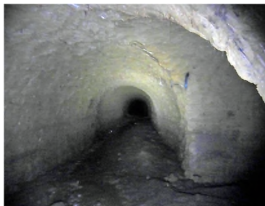
図-5 地下壕の内部の様子(No.1 孔)
