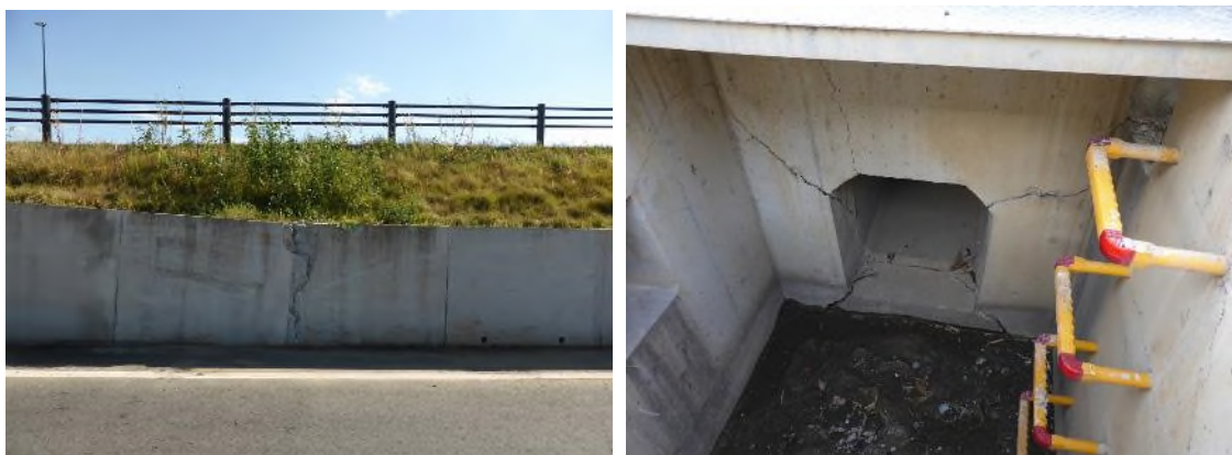
写真2 熊本県内の火山灰質粘性土分布域での構造物損傷事例
