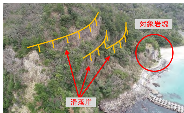
写真-4 背後滑落崖の様子
