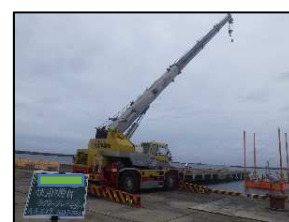
写真-6 点検状況
