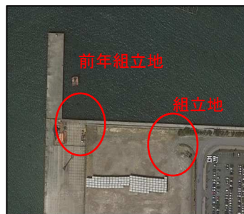
写真-1 スパット台船組立予定地
