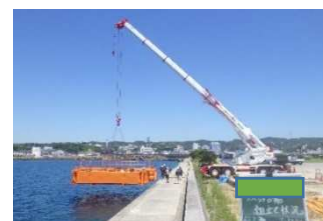
写真-2 台船吊り上げ写真
