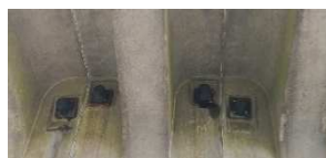
写真-4 頭部補修工前
