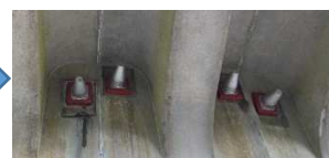
写真-5 頭部補修工後
