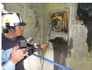
写真-2 背面調査状況
