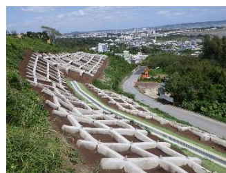
写真-2 斜面状況
