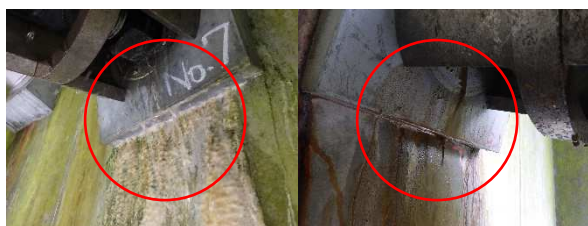
写真-1 リフトオフ時の地下水排出状況
