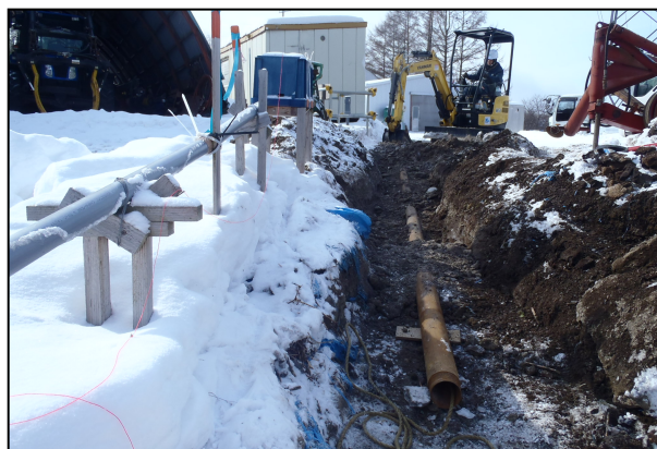
写真-3 埋設状況
