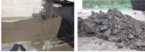
写真-3 施工機械から排出された改良土
