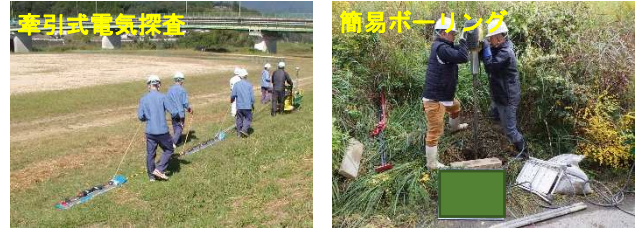
写真-1 現地調査状況(牽引式電気探査, 簡易ボーリング)
