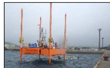
写真-4 台船固定状況
