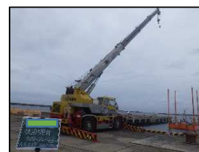
写真-6 点検状況
