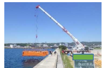
写真-2 台船吊り上げ写真
