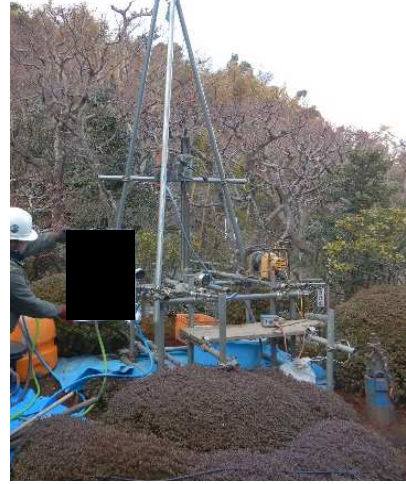
写真-2 軽量型ボーリングマシン(電動型)作業状況
