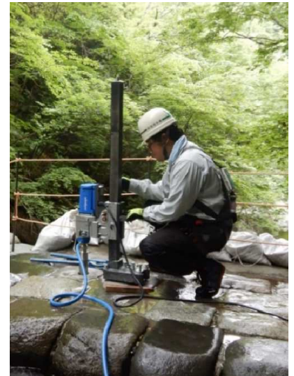
写真-1 コアドリルによる掘削状況
