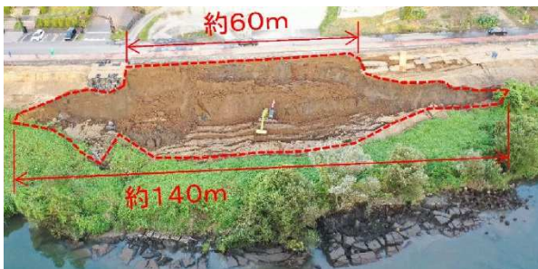
図-1 崩壊地の状況
