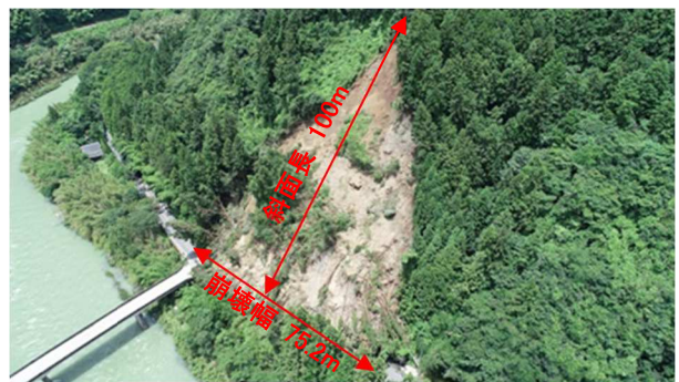
写真-1 斜面崩壊状況
