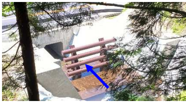
写真-2 閉塞軽減工を設置し函渠に導流する例(その1)
