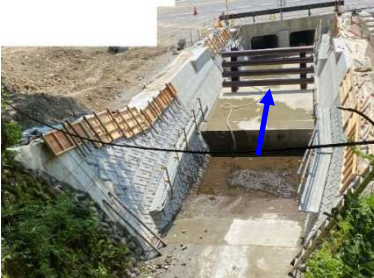
写真-3 閉塞軽減工を設置し函渠に導流する例(その2)
