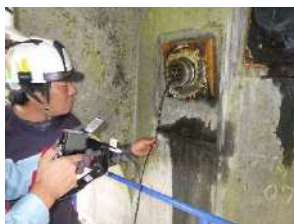
写真-2 背面調査状況
