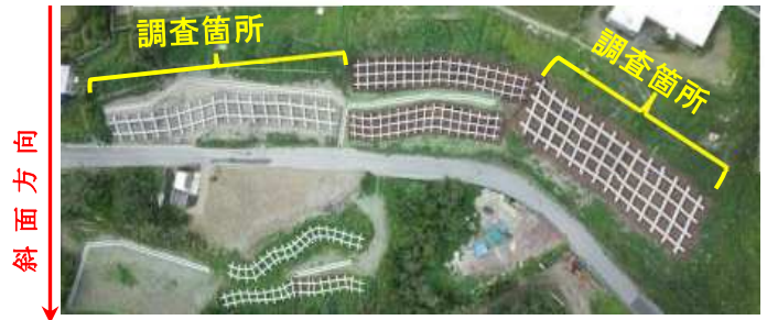
写真-1 調査地全景(調査箇所)
