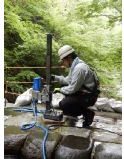
写真-1 コアドリルによる掘削状況
