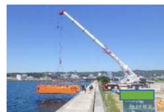
写真-2 台船吊り上げ写真
