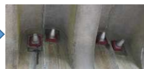
写真-5 頭部補修工後
