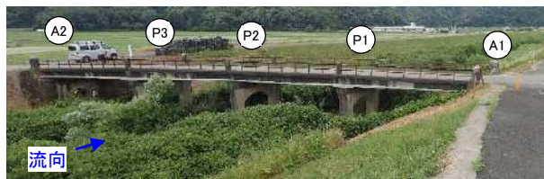
写真-3 対象旧橋の現状
