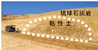
図-1 流入粘土が表れた切土面
