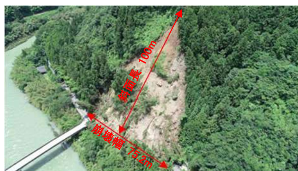
写真-1 斜面崩壊状況
