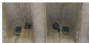
写真-4 頭部補修工前
