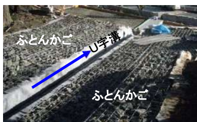
写真-1 不安定土砂の発生抑制を図った例
