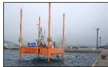
写真-4 台船固定状況
