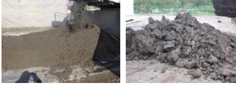
写真-3 施工機械から排出された改良土 (左:プラント土質 A 右:プラント土質 B)
