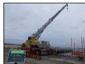
写真-6 点検状況
