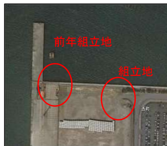
写真-1 スパット台船組立予定地
