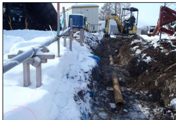
写真-3 埋設状況
