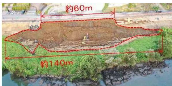
図-1 崩壊地の状況
