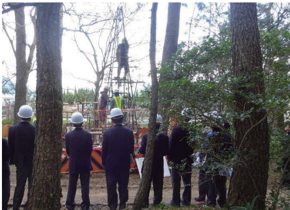
写真-4 ボーリング作業見学状況
