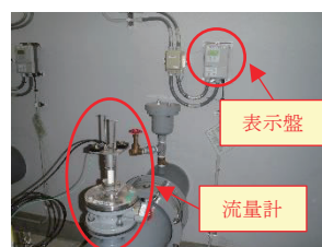
写真-1 電磁流量計
