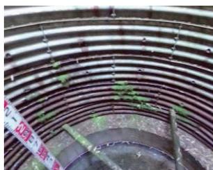
写真-6 ライナープレートの変状(せり出し)
