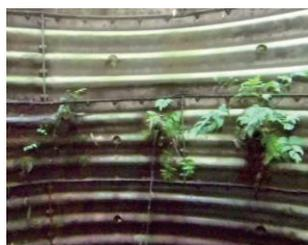
写真-7 集水管の閉塞(植生)
