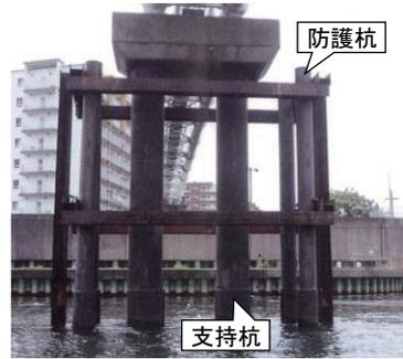
写真-3 鋼管杭(支持杭と防護杭)の設置状況
