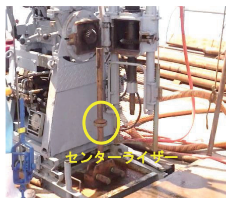
写真-1 センターライザー設置状況
