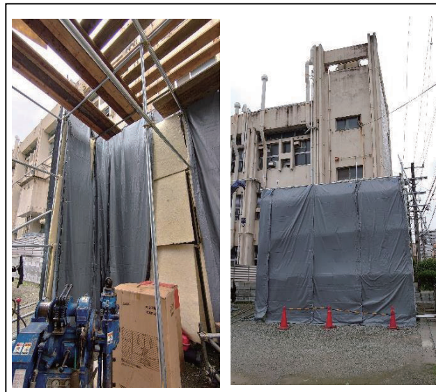
写真-1 騒音対策状況
