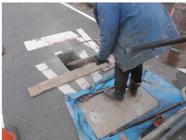
写真-2 ケーシング挿入
