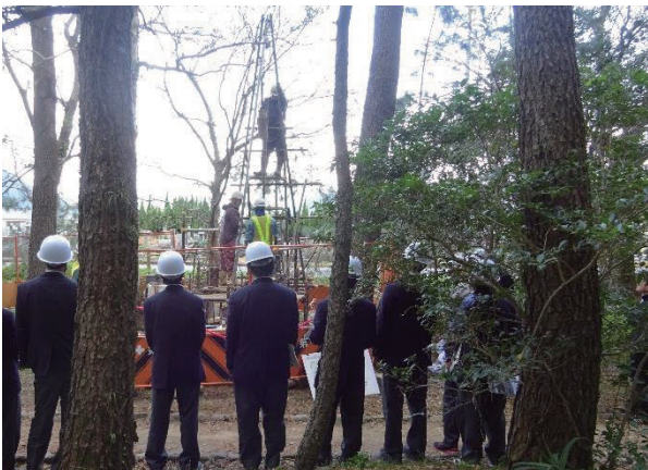
写真-4 ボーリング作業見学状況
