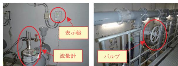
写真-1 電磁流量計
