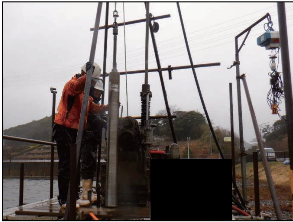
写真-1 ロータリー式三重管サンプラー
