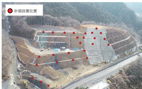
図-8 長大のり面における計器設置例
