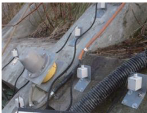
写真-1 法枠への設置状況
