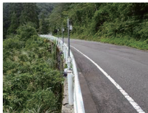
写真-2 擁壁への設置状況
