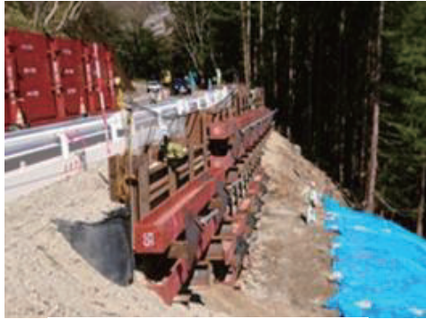
写真-4 仮設土留めの全景
