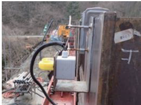
写真-5 仮設土留めへの設置状況
