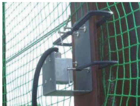
写真-3 仮設防護柵への設置状況
