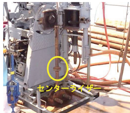
写真-1 センターライザー設置状況
