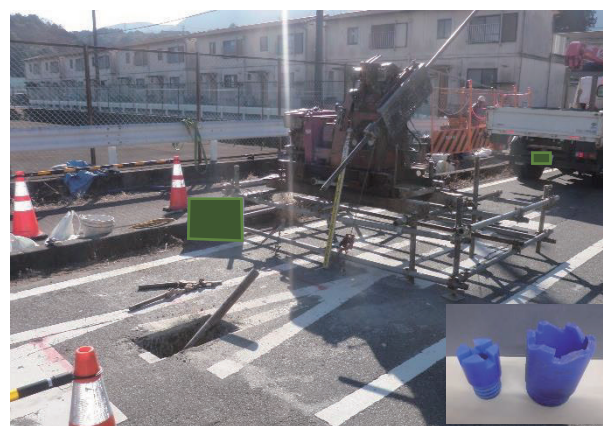
写真-1 現場状況と使用した強化プラスチックビット
