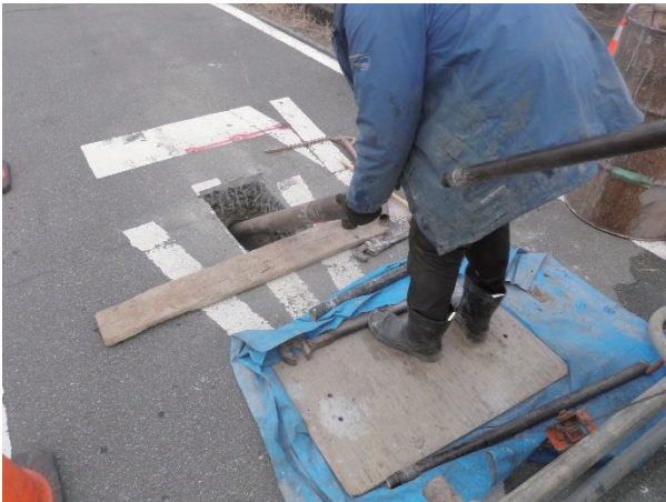
写真-2 ケーシング挿入
