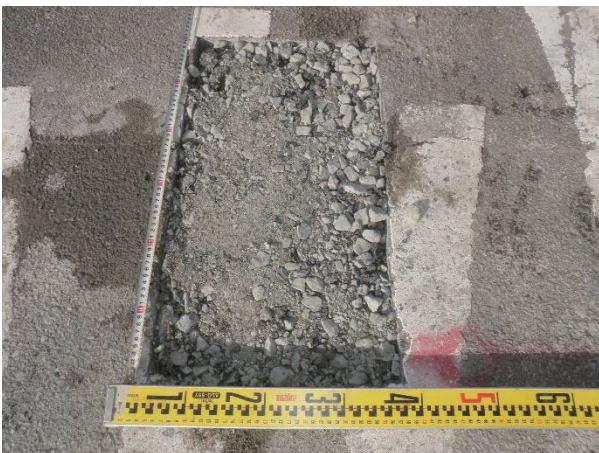
写真-3 日々の埋め戻し
