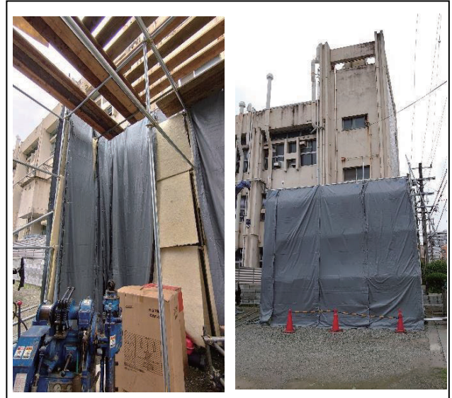
写真-1 騒音対策状況 左:設置状況 右:対策全景
