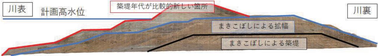
写真-2 開削断面のオルソ写真
