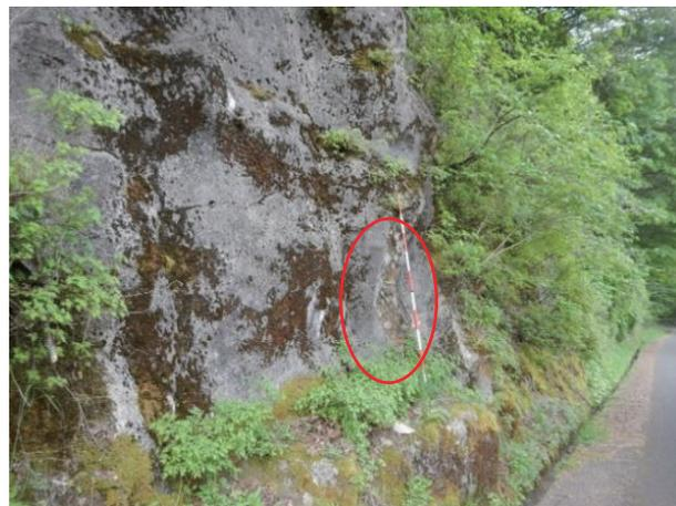
写真-2 モルタル吹付工の剥離進行・ラス金網の露出
