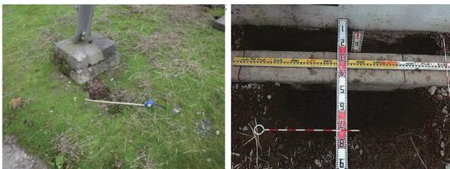
写真-1 陥没発生状況
