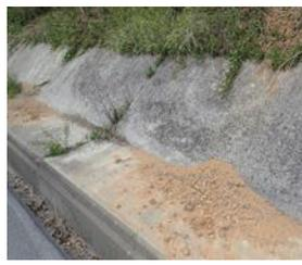
写真-2 土砂流出状況
