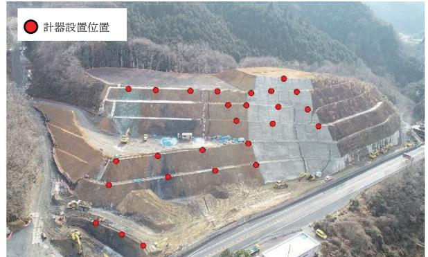
図-8 長大のり面における計器設置例
