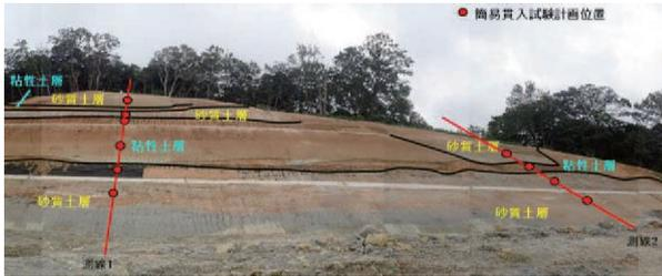
写真-7 現地状況及び簡易貫入試験実施位置
