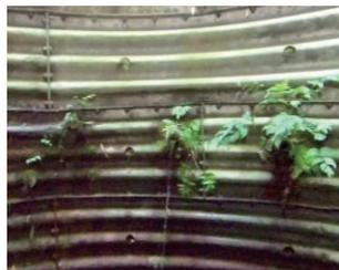
写真-7 集水管の閉塞(植生)
