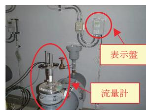
写真-1 電磁流量計
