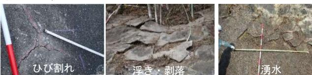
写真-2 吹付モルタル法面の変状
