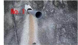
写真-6 No.1 孔地下水排出状況
