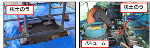
写真-2 泥水の流出対策
