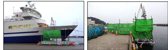
写真-1 足場仮設の状況(左:No.2、右:No.4)
