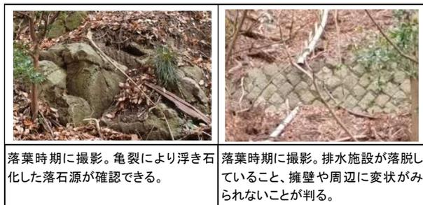
写真-3 UAV で林間に侵入し撮影した事例
