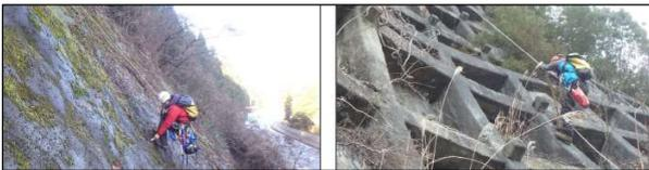
写真-1 ロープワークを利用した急峻な法面の点検状況例
