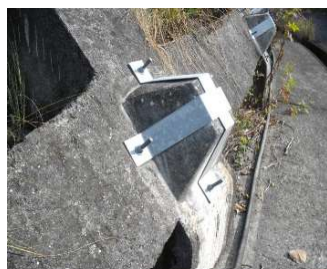
(a) アンカーボルト +帯鋼板
