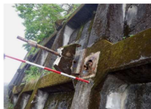
写真-1 アンカーの飛び出し
