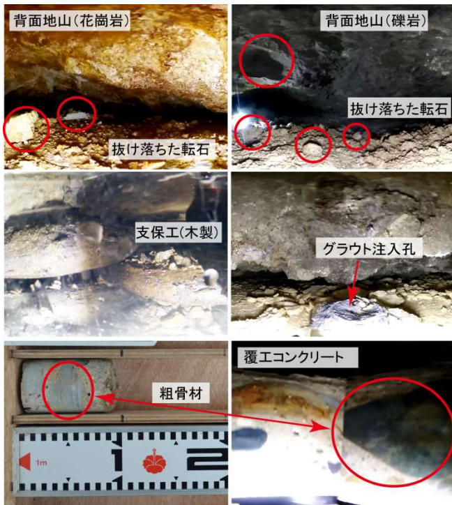
写真-2 全地球カメラで撮影された覆工背面状況
