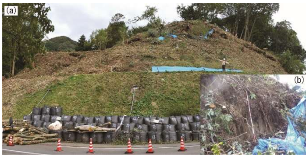
写真-1 (a) 崩壊斜面全景 (b) 地すべりの滑落崖
