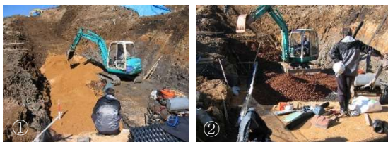
写真-2 ①基礎地盤の置き換え状況、②補強土盛土内の施工状況、
