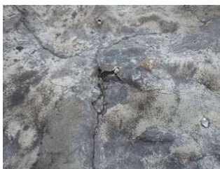
写真-4 法面のひび割れ・剥離
