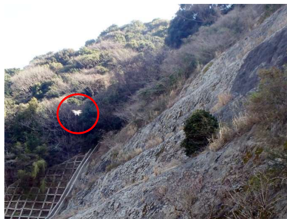
写真-2 UAV による点検状況
