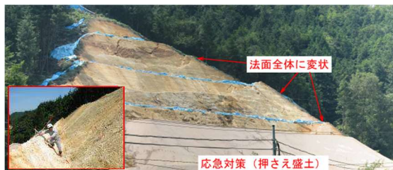
写真-2 トップリング崩壊現場(切土中法面)
