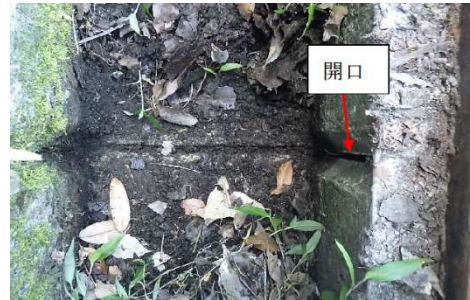
写真-1 現地状況写真(U字側溝目地部の開口)
