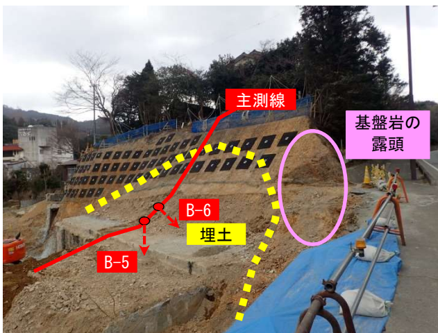
写真-2 施工途中の状況写真と追加調査位置
