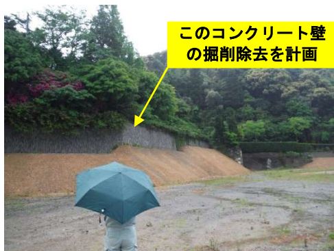
写真-1 コンクリート壁(押え盛土は仮設)
