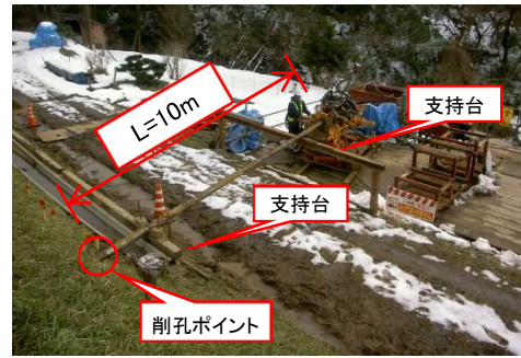
写真-8 削孔状況
