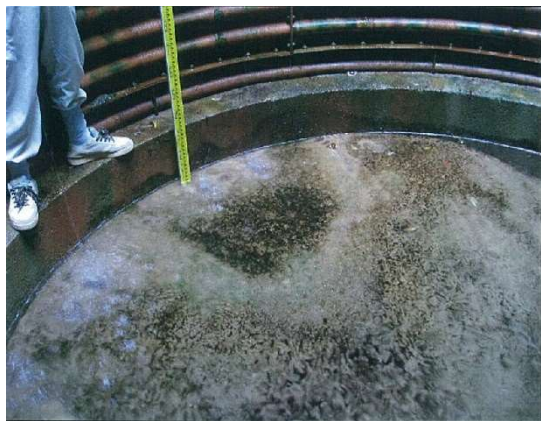
写真-1 集水井の堆砂状況(隣接工区)
