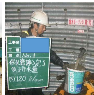
写真-6 排水量測定状況
