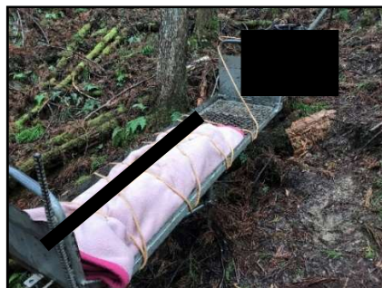
写真-3 モノレールによるコアの運搬状況
