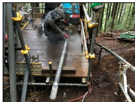
写真-1 コア切断時の樋の使用
