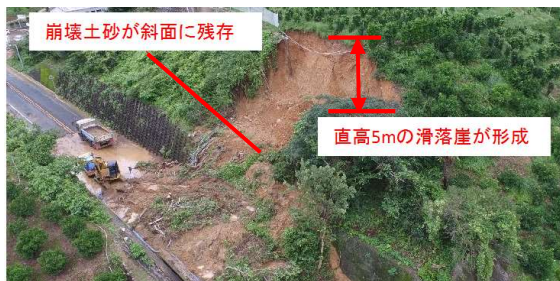
図-4 白浦地区(215K890)のり面崩壊の全景
