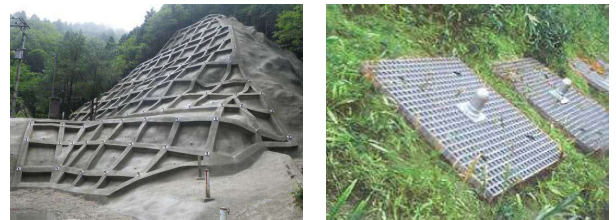
図-6 施工イメージ図(左:吹付砕工、右:独立受圧板)
