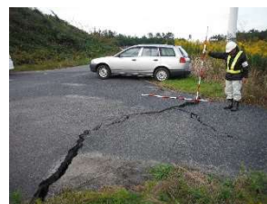
写真-1 舗装の亀裂
