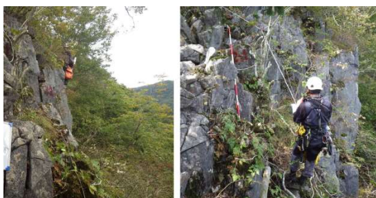
図-2 壁面落石調査状況
