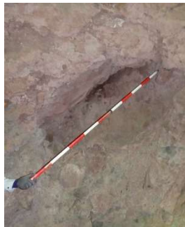
写真-3 凝灰角礫岩の礫の抜け落ち跡
