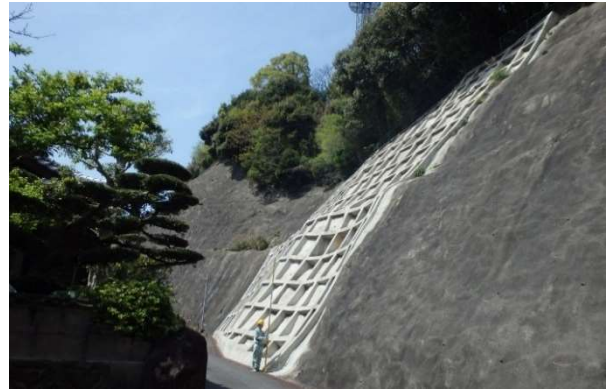
写真-4 対策工の完成後
