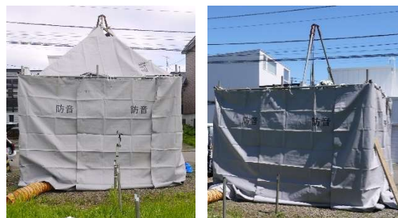
写真-2 シートの設置(左:天井密閉型、右:解放型)
