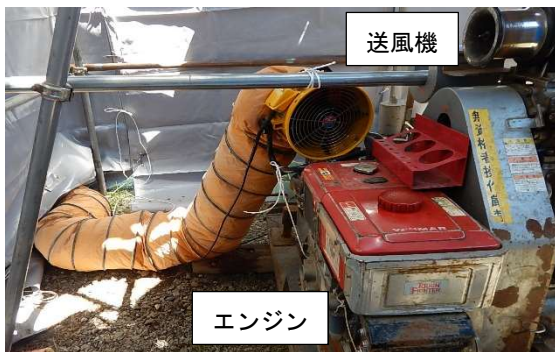
写真-4 排気対策の送風機設置状況
