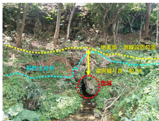
図-3 テスト地点②（水源空洞）の現地状況写真
