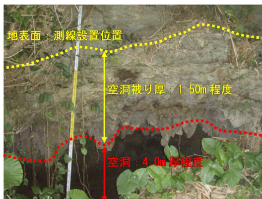
図-2 テスト地点①（鍾乳洞）の現地状況写真
