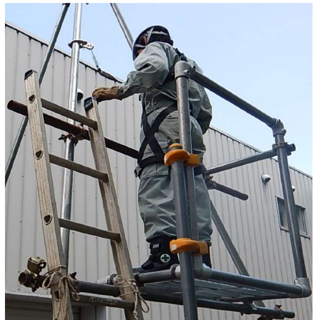
写真-3 改良した手すり付きステップ
